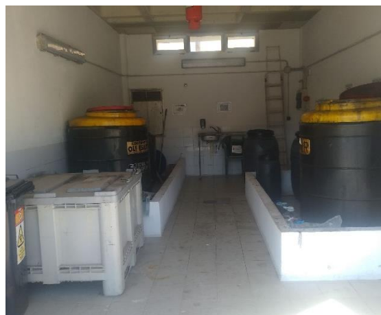
Figura 88: Interior del punto limpio de Port de Ciutadella (Menorca).
