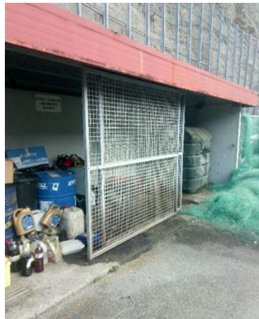
Figura 58: Punto limpio del puerto de Lastres.
