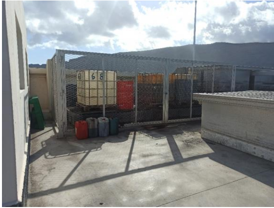
Figura 114: Punto limpio del puerto de Caleta del Sebo.
