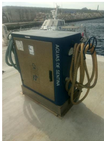
Figura 78: Bomba de aspiración de Port de Cala Ratjada.
