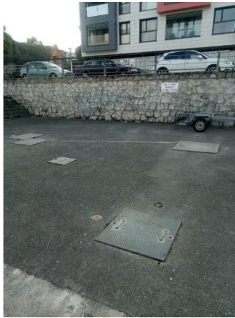
Figura 41: Depósitos para la recogida de residuos líquidos MARPOL en Ribadesella.
