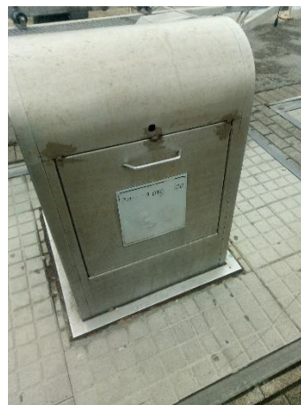
Figura 143: Contenedor soterrado de residuos orgánicos en Castro Urdiales.
