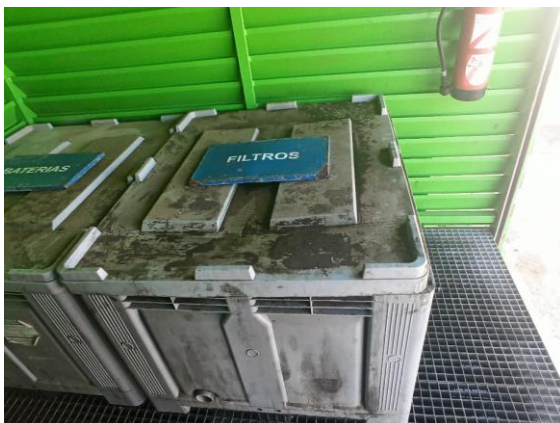
Figura 244: Contenedor para almacenar filtros del punto limpio del puerto de Cabo de Palos.
