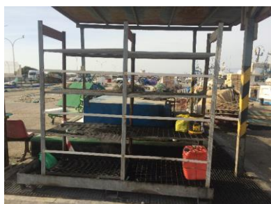
Figura 16: Estantería para envases de residuos peligrosos de la estación de punto limpio del puerto de Motril.
