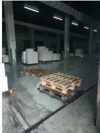
Figura 235: Interior de la lonja del puerto de A Coruña.
