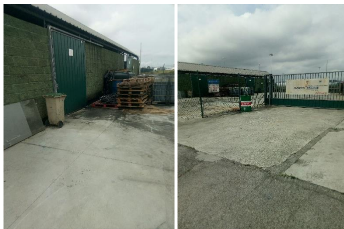
Figura 143: Punto limpio del puerto de Santander.
