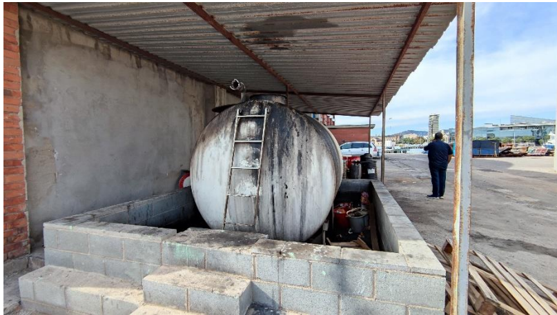
Figura 182: Punto limpio con residuos pesqueros en el puerto de Barcelona.
