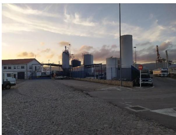
Figura 238: Planta de Codisoil S.A. en el puerto de Marín.
