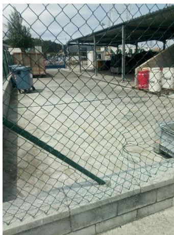
Figura 61: Punto limpio del puerto de Avilés.
