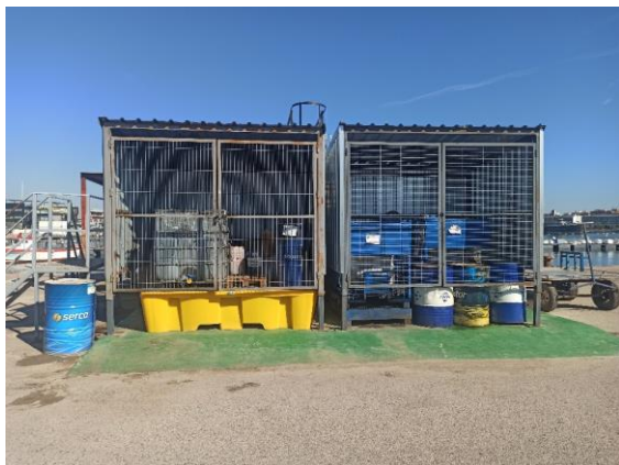
Figura 212: Punto limpio del puerto de Valencia.
