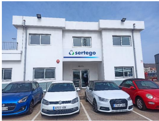
Figura 109: Planta de tratamiento de residuos MARPOL I en el puerto de Las Palmas de Gran Canaria.
