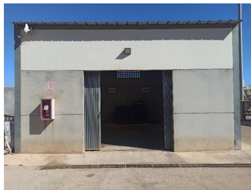
Figura 213: Punto limpio del puerto de Gandía.
