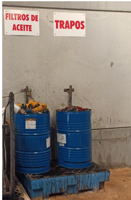
Figura 229: Contenedores de residuos peligrosos (filtro y trapos contaminados) en el puerto de Gandía.
