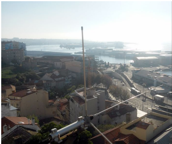
Instalación de la antena
